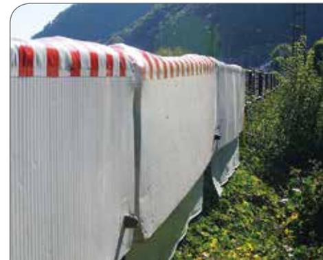
Oben: Aufblasbare spot-Lärmschutzmodule
